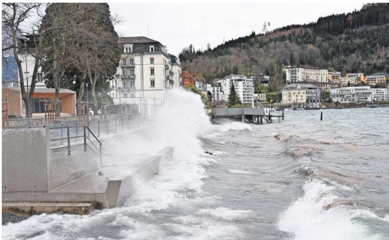
Eine stürmische Bewährungsprobe bereits hinter sich: Das neu gestaltete Seeufer in Brunnen hat den tosenden Wellen problemlos standgehalten. Bild: Josias Clavadetscher
