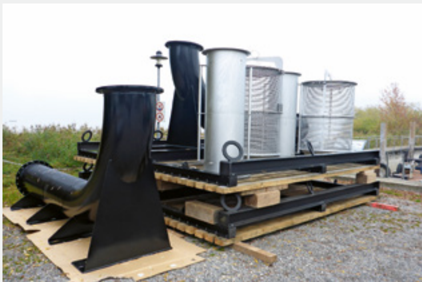
Fig. 10 Vormontierte Seiherplattformen und Seiherkörbe kurz vor der Endmontage.
