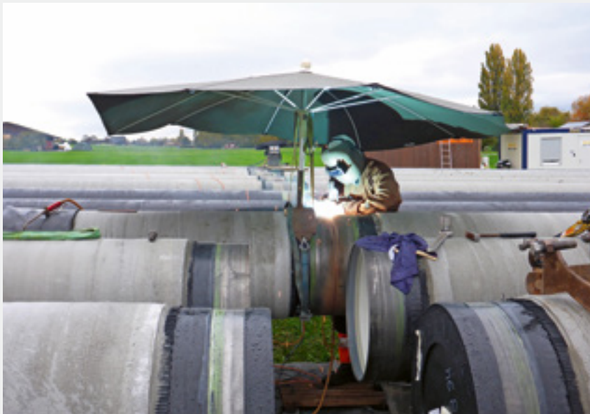
Fig. 2 Schweissarbeiten am Rohrstrang für grabenlosen Leitungsbau.
