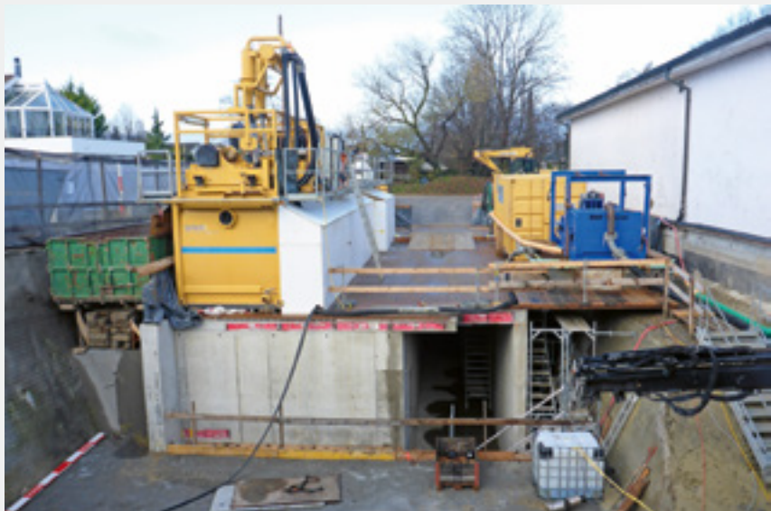
Fig. 4 Weitere Einrichtungen für die Bohrarbeiten.
