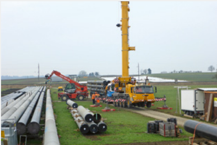
Fig. 1 Rohrlager und Rohrschweisplatz in Güttingen.
