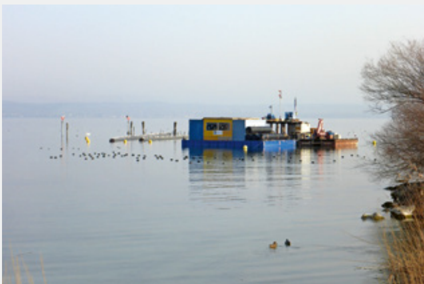
Fig. 9 Pontoneinheiten neben dem schwimmenden Rohrlager.
