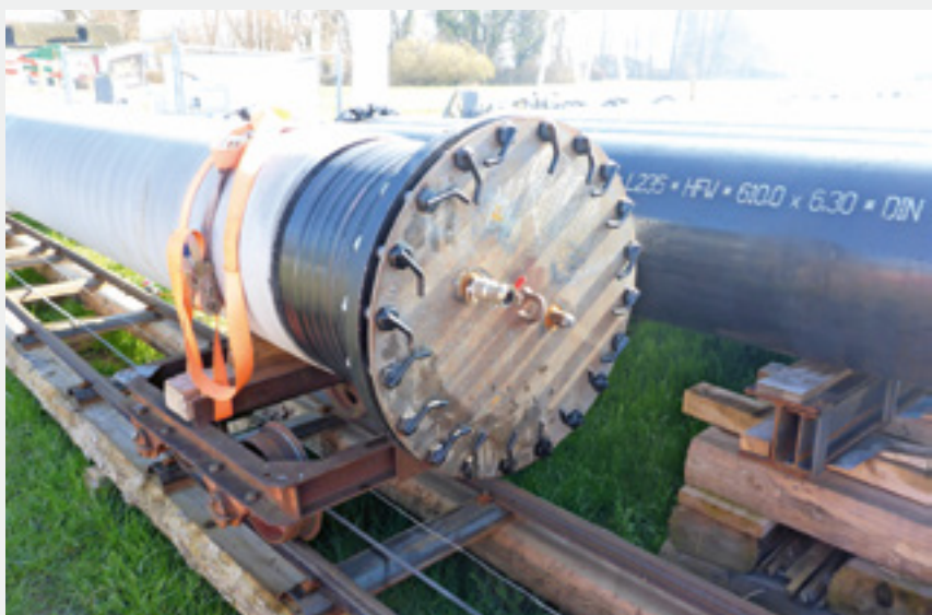
Fig. 6 512-m-Rohrstrang auf der Einwasserungsbahn.
