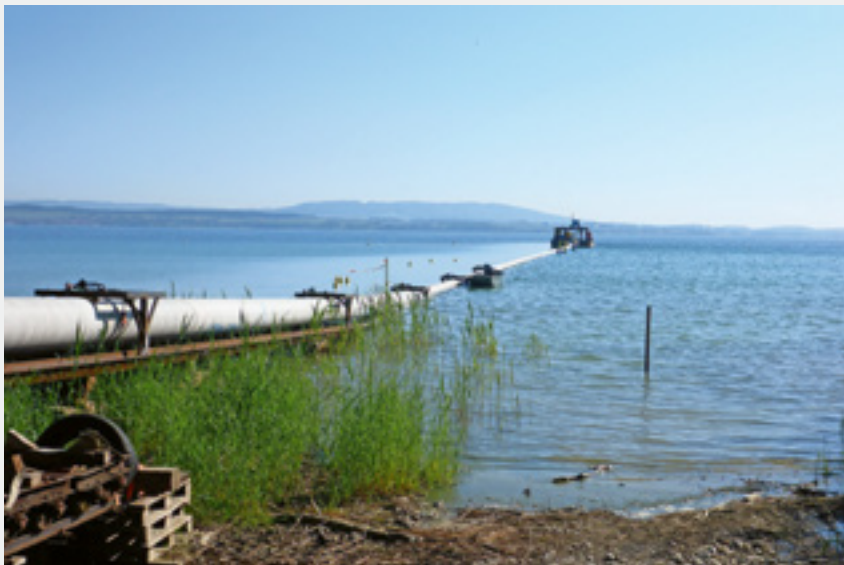
Fig. 7 512-m-Rohrstrang beim Einwassern.
