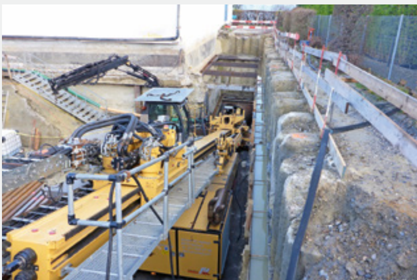
Fig. 3 Bohrgerät in der Baugrube am Seewasserwerk in Kesswil.
