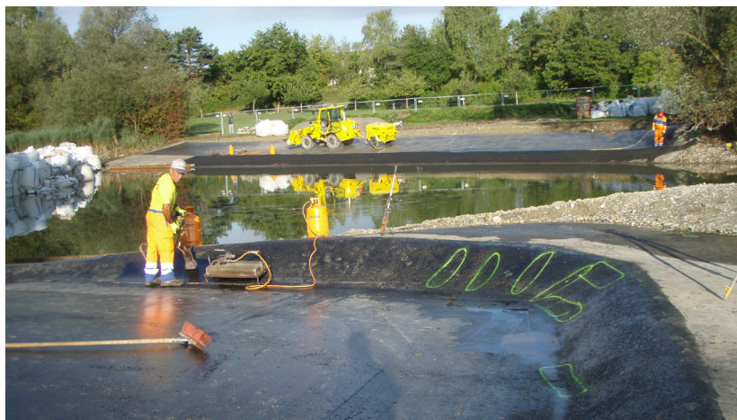
Einbau der Asphaltabdichtung im Uferbereich des Grossweihers
