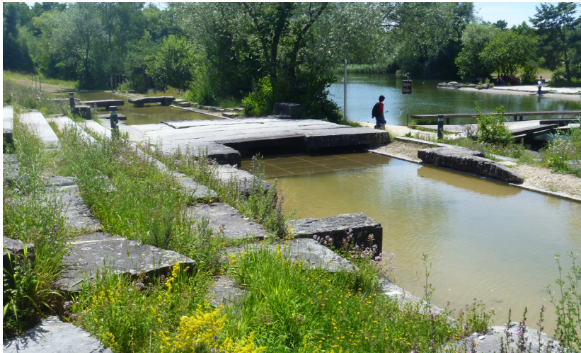
Neu abgedichtet und wieder in den Park eingepasst: der Reflecting Pool . Gitter unter der Wasseroberfläche am Übergang tragen zur Unfallverhütung bei.
