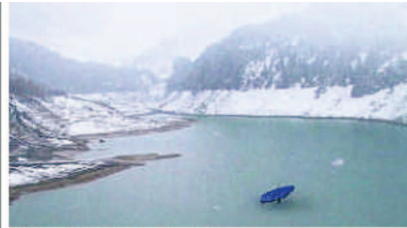
Als Pilotprojekt soll eine Solaranlage im Marmoreraee schwimmen.
