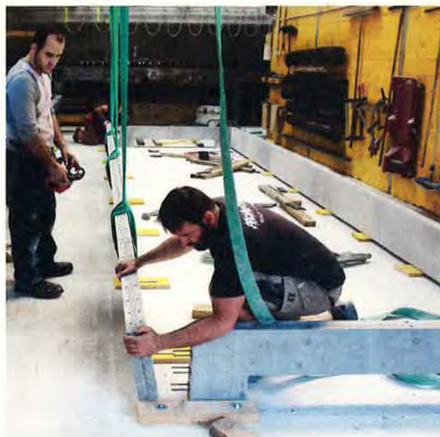
Rahmenkonstruktion der Brücke: Der Rahmen und die Platte (nicht im Bild) bestehen aus 40 mm starken cpc-Platten. Für den Rahmen wurden je zwei vollflächig miteinander verklebt.
