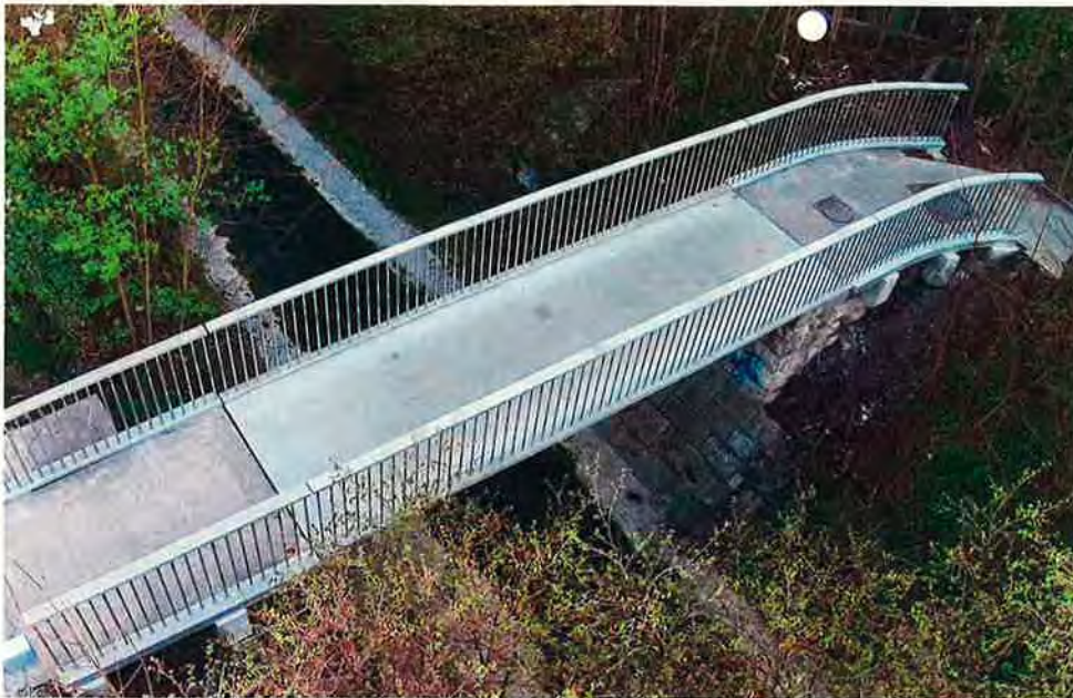
Wie ein Puzzleteil ist die neue Eulachbrücke in den Bestand eingefügt.
