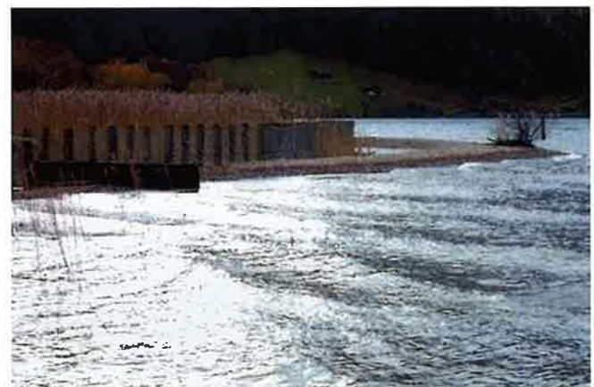
Abbildung 6: Verlandeter Einlauf zu den Hechtlaiplätzen mit früheren Sofortmassnahmen. Figure 6: Entrée abstruée vers les frayères à brochets avec mesures d'urgence antérieures.
