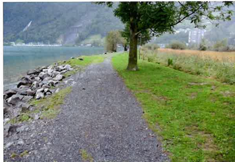
Abbildung 1: Künstlich geschütteter Damm zwischen Flachmoor und Vierwaldstättersee mit Blacksteinschüttung.
